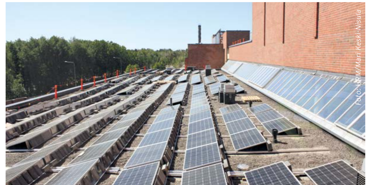
Under sommaren 2016 monterades solpaneler på taket till Viksbacka avloppsreningsverk.
